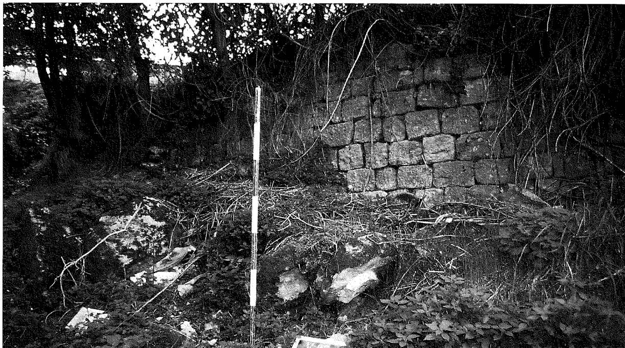
Fig. 8. Volterra, San Giusto: particolare della tecnica edilizia.
