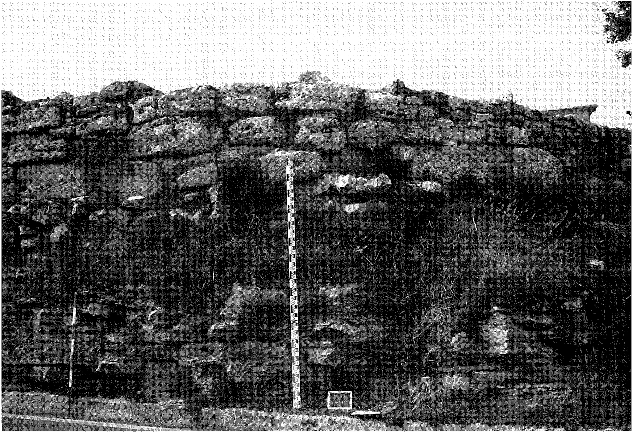
Fig. 5. Volterra, San Giusto: particolare della tecnica edilizia.
