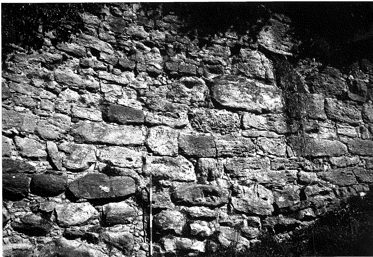
Fig. 4. Volterra, località Penera: particolare della tecnica edilizia.
